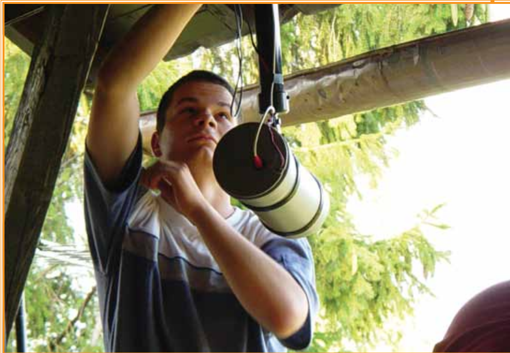
Uroš Krajner S57WOT med montažo kamere z rotatorjem ATV oddajnika S55TVS na postojanki na Borseki nad Rečico ob Savinji leta 2004
